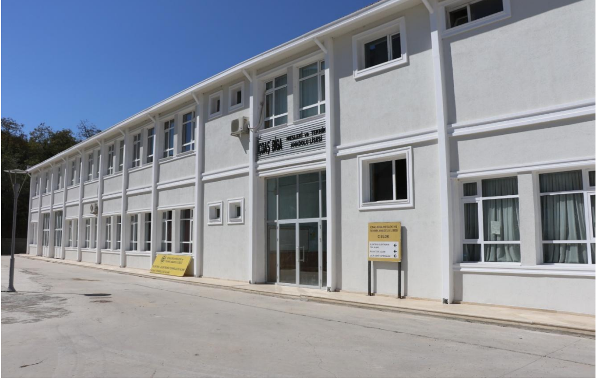
Ön Cephe Yeni Görünüm
