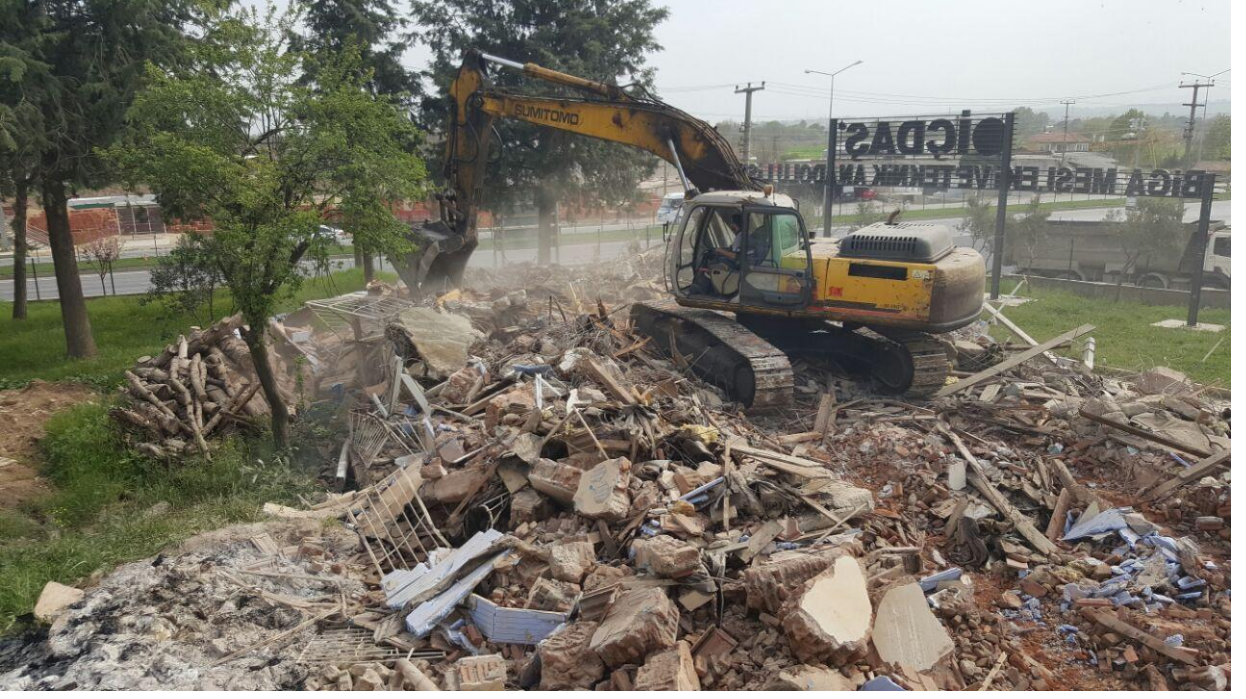
Basketbol Sahası İnşaatı
