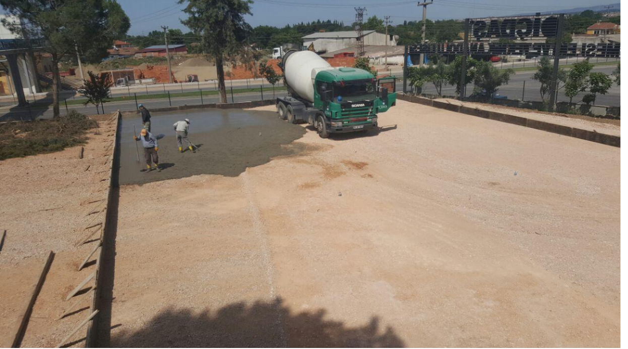
Basketbol Sahası İnşaatı
