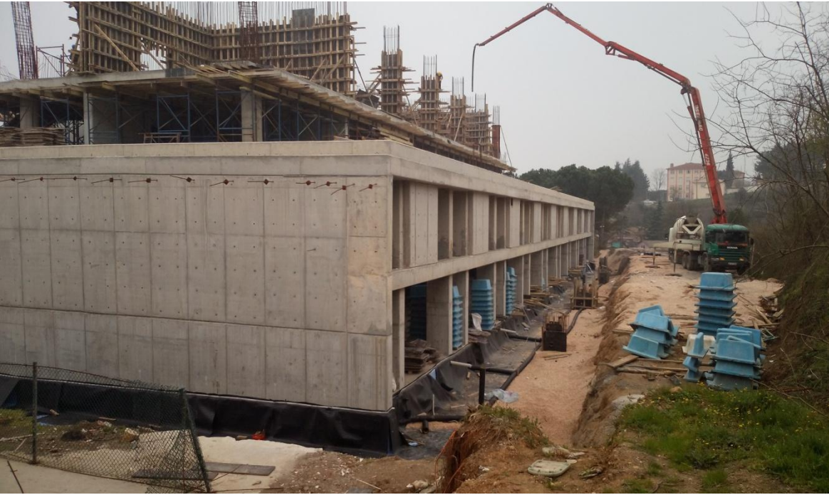
A Blok İnşaatı
