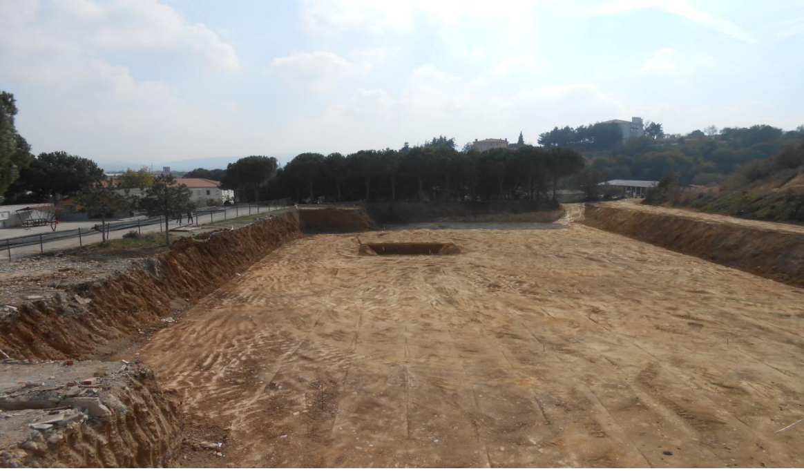
A Blok İnşaatı Kazısı
