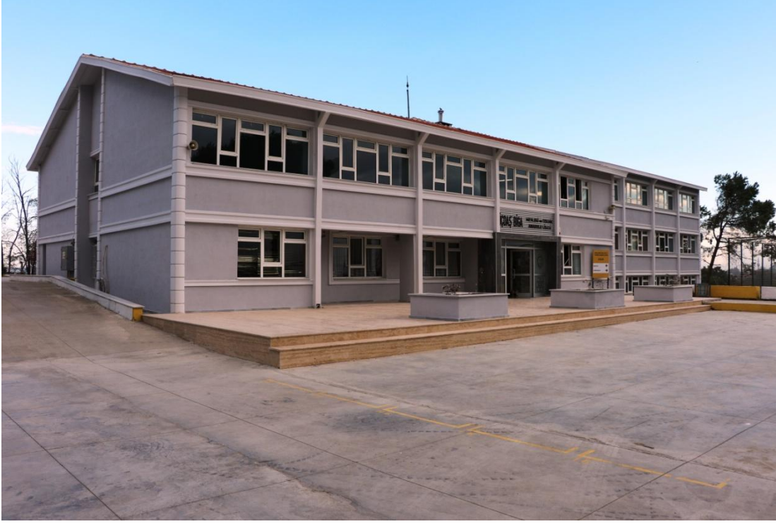
Ön Cephe Yeni Görünüm
