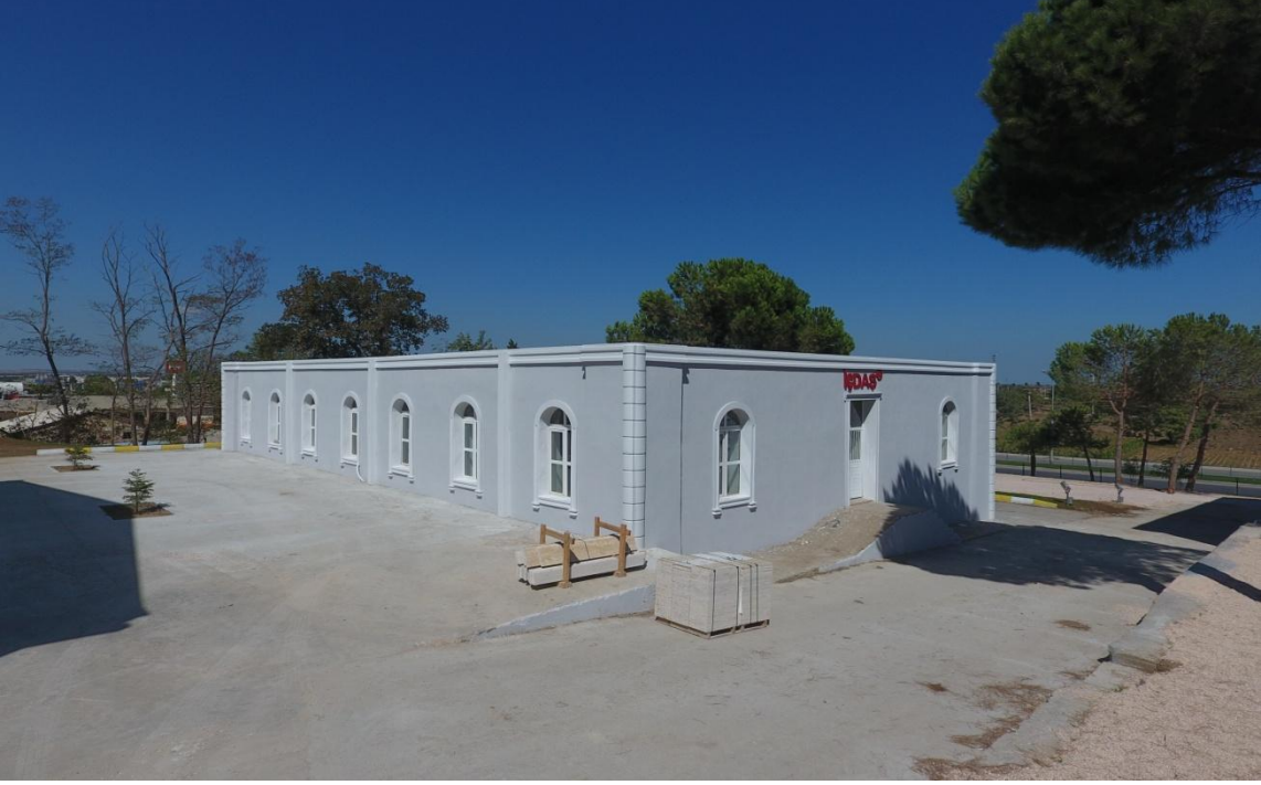
Ön Cephe Yeni Görünüm
